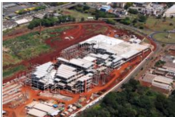
Obras do Projeto do Boulevard Londrina
