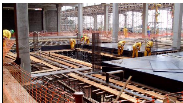
Obras do Projeto do Boulevard Londrina
