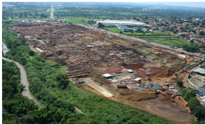
Obras do Projeto do Passeio das Águas
