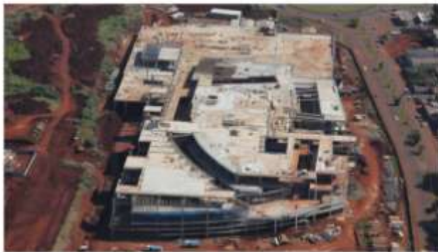
Obras do projeto do Boulevard Londrina
