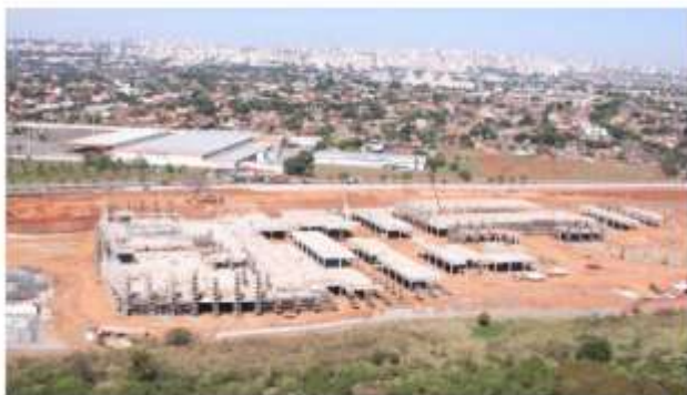
Obras do projeto do Passeio das Águas
