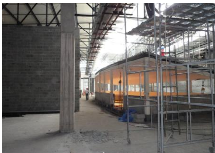
Obras de Expans o do Campo Limpo
