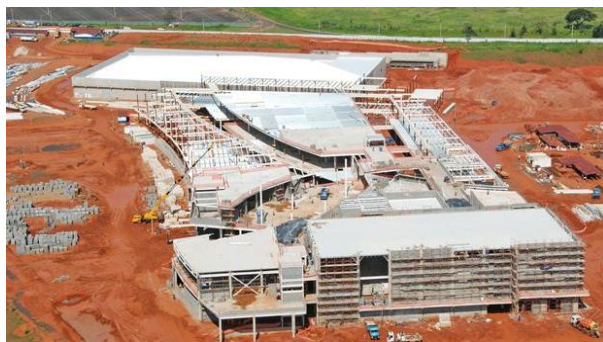
Obras do Uberlândia Shopping
