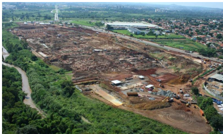
Passeio das Águas Construction Site
