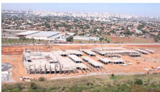
Passeio das Águas Construction Site
